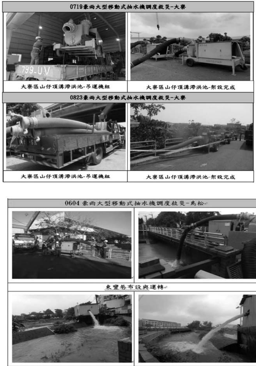
圖十一 大寮、鳥松地區大型移動式抽水機支援淹水救災情形
