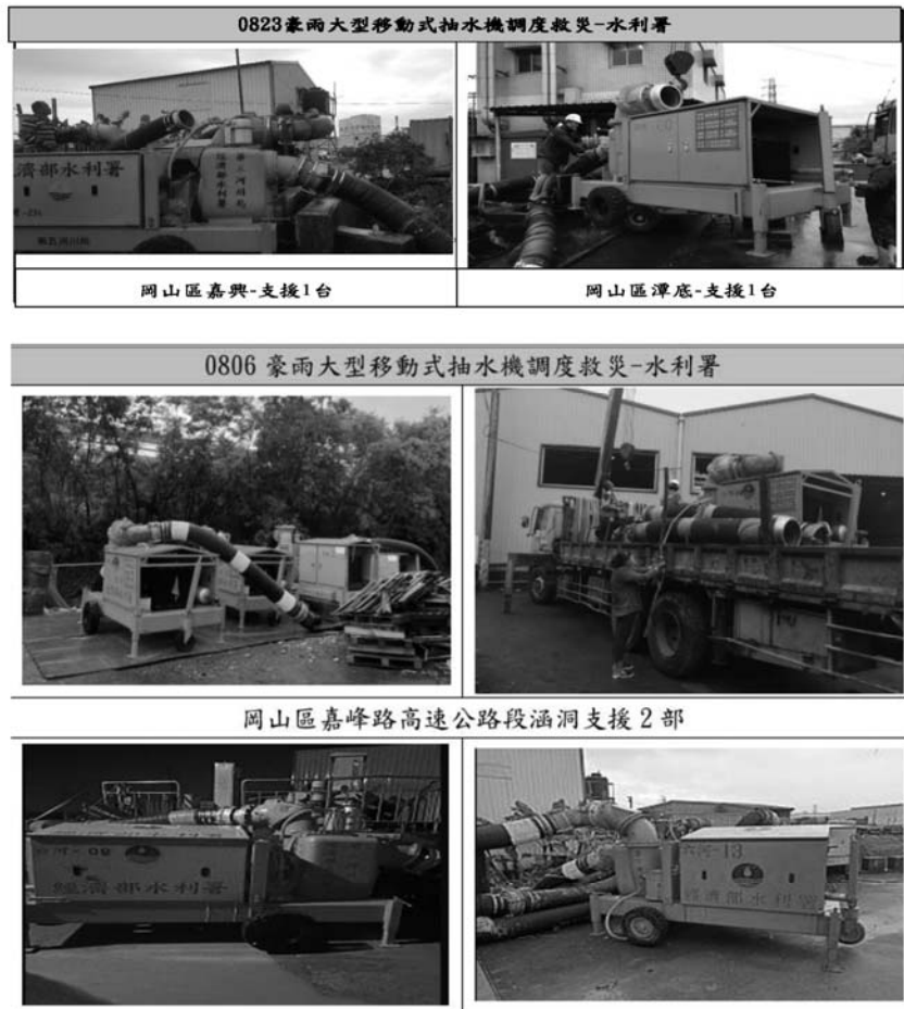
圖八 岡山地區大型移動式抽水機支援淹水救災情形
