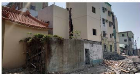
第三拍賣場舊址危樓拆處後露出周邊民宅之立面現況
