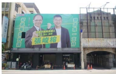
既有建物外牆整修、表面處理、入口意象現況
