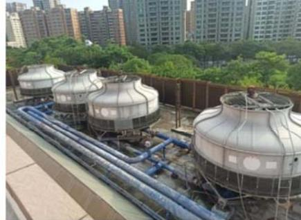
本館散熱水塔為冰水主機之輔助設備，一併更新有助於效率提升加乘效果
