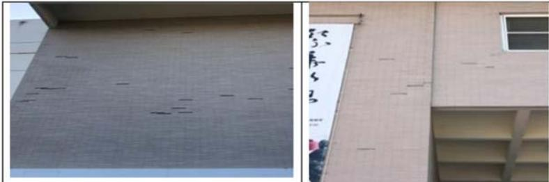
岡山文化中心行政棟北、西二面外牆時有磁磚脫落，具有安全之虞，亦造成外觀觀瞻不佳，磁磚脫落處更形成外牆雨水滲入入口。
