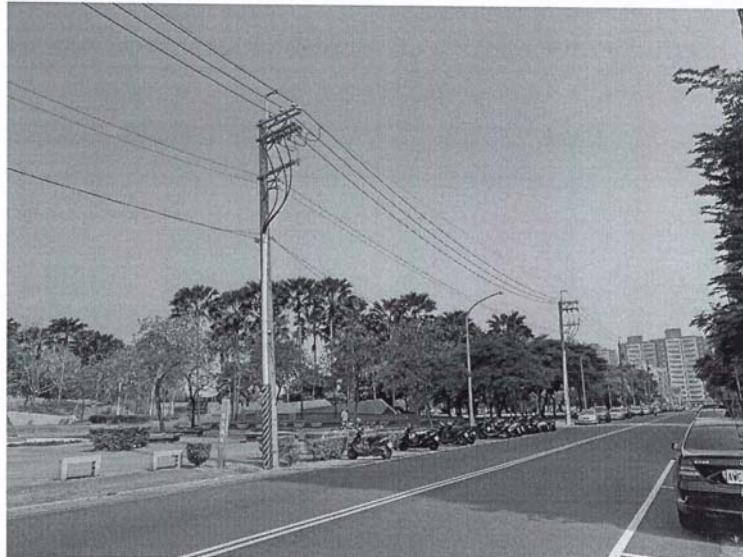
圖 3：岡山區河堤公園內東側(臨仁義路側，仁義路 6 號與仁義路 66 號之對面)之台灣電力公司的 3 相、11.4KV 架空高壓輸配電線路及電桿現況。
