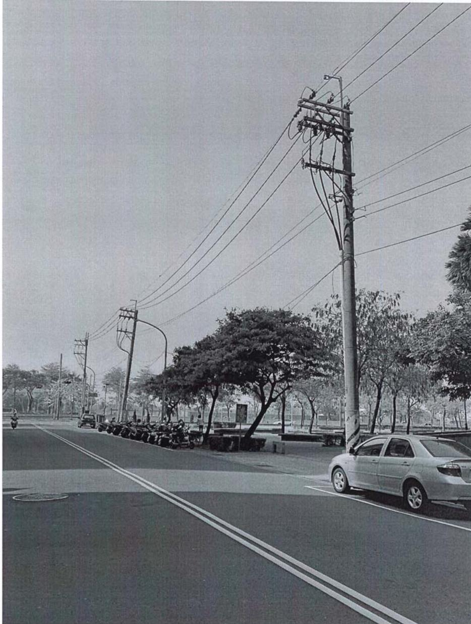
圖 5：岡山區河堤公園內東側(臨仁義路側，仁義路 66 號之對面)之台灣電力公司的 3 相、11.4KV 架空高壓輸配電線路及電桿現況。
