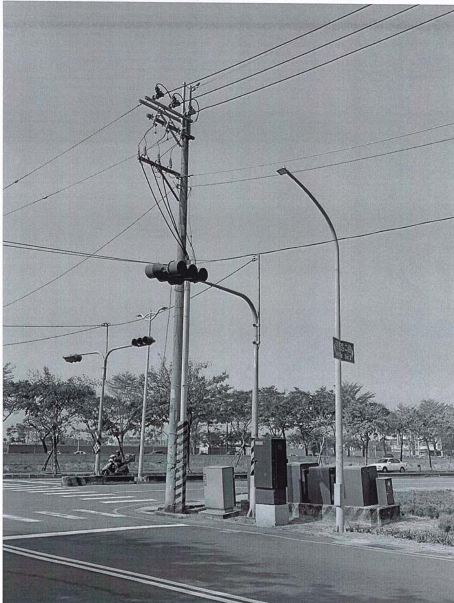
圖 2：岡山區河堤公園內東側(臨仁義路側，仁義路 6 號與仁義路 66 號之對面)之台灣電力公司的 3 相、11.4KV 架空高壓輸配電線路及電桿現況。
