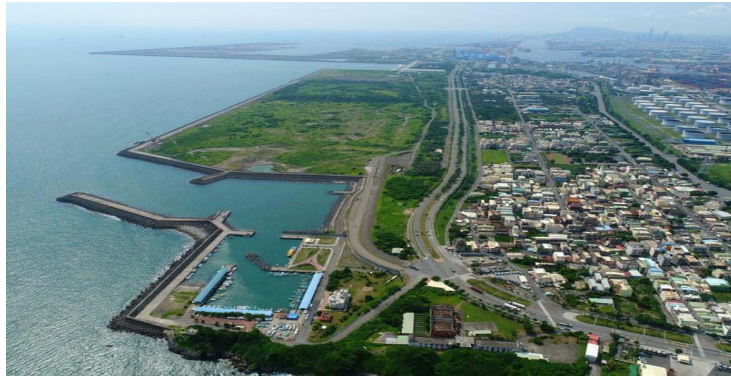
圖 1. 新材料循環產業園區空拍圖
