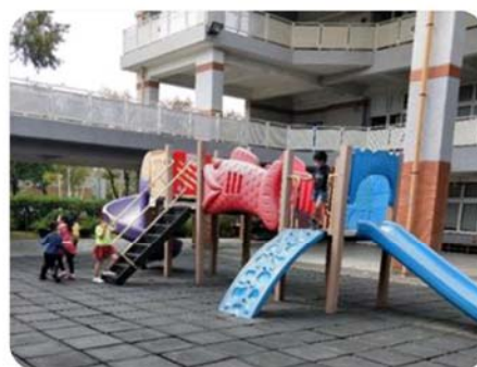
鳳翔國小不合格遊具 未予隔離並禁止兒童使用
