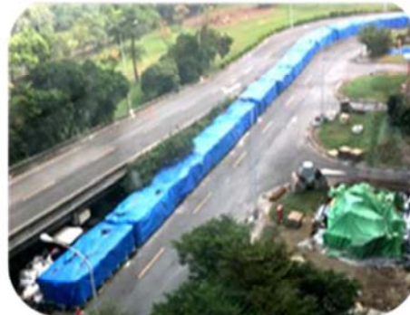
岡山垃圾資源回收（焚化）廠內 飛灰穩定化物暫置情形
