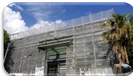
205 廠新建工程情形
