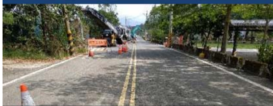
杉林區高129 (施工前)
