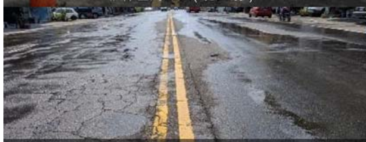
美濃區成功路 (施工前)
