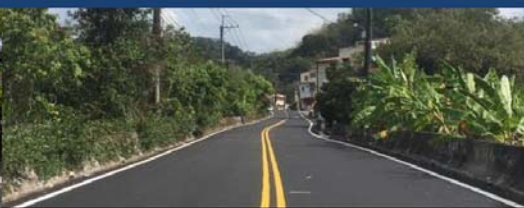
杉林區高129 (施工後)
