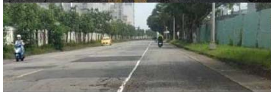
前鎮區大華一路 (施工前)
