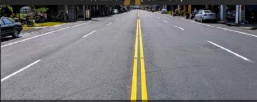
美濃區成功路 (施工後)
