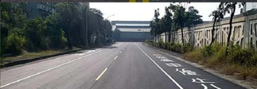
前鎮區大華一路 (施工後)
