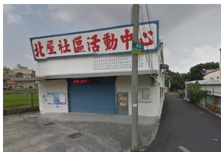
仁武區北屋社區活動中心
