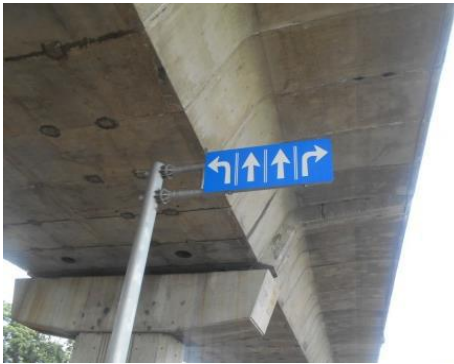
圖 43 大寮區市道 188 與華中路口增設輔 1 標誌
