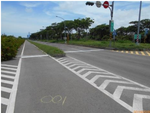
圖 45 小港區中林路與南星路劃設停止線、槽化線
