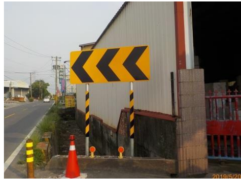
圖 44 烏松區水管二號橋增設輔 2 標誌
