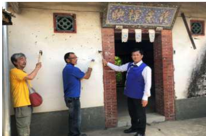
[圖 26] 邱義生夥房整修工程開工
