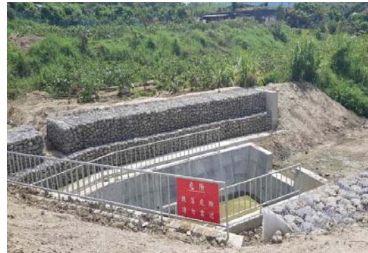
田寮區七星里大山橋排水護岸災修工程
