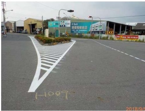
圖 46 大寮區成功路（高 61） 劃設槽化線、導引線
