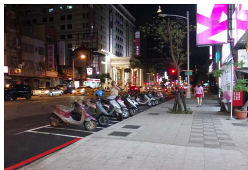
圖 20 苓雅區成功路施工前
