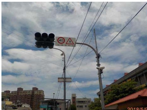
圖 53 鳳山區龍成路五甲國中設置交通寧靜區牌面
