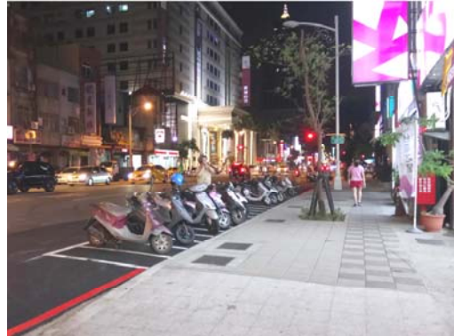
圖 30 苓雅區成功路施工後
