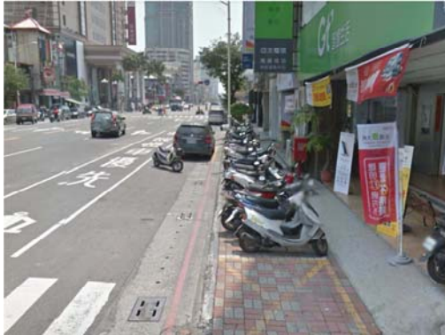
圖 30 苓雅區成功路施工前
