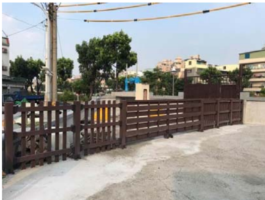
前鎮區鎮昌一巷簡易式抽水站工程
