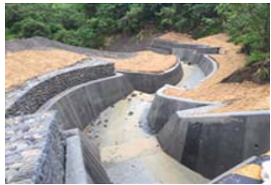
杉林區十張犁 193-652 地號等防砂壩 掏空修復工程
