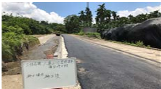
六龜區田營底野溪災修工程
