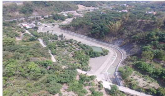
茄苳湖吉橋下游整治工程
