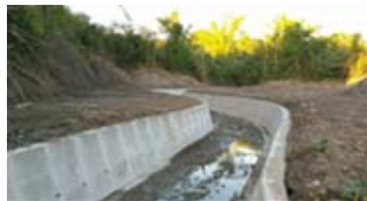
旗山區楊厝巷鳳明橋上游野溪整治工程
