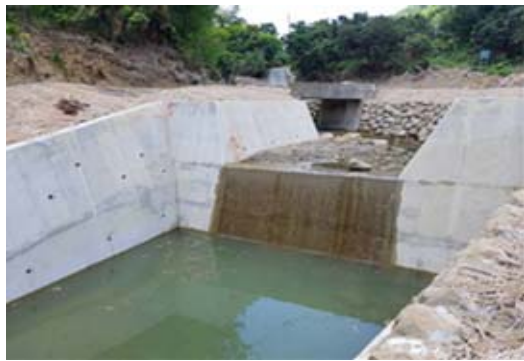
高 121 線玉門野溪整治工程
