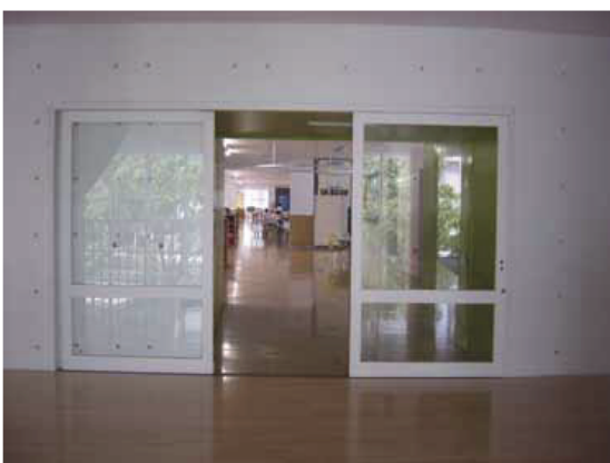
■ 写真 7-1-3 地域開放部分と非開放部分との区画管理の例 ・見通しのきくガラスドアで領域を区分けしており、施錠することも可能となっている。
