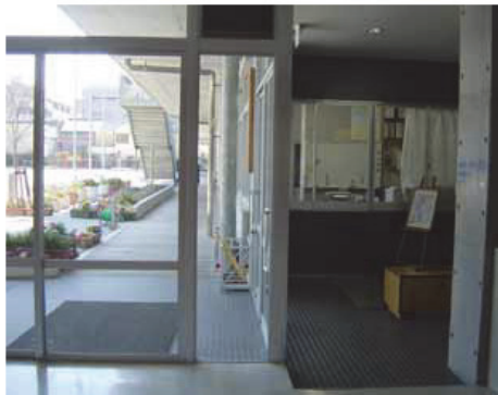
■写真 4-2-4 視認性が高い出入口の例 ・玄関の扉をガラスにすることによって、高い視認性を確保している。
