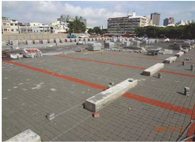
金馬新村平面停車場施工照片
