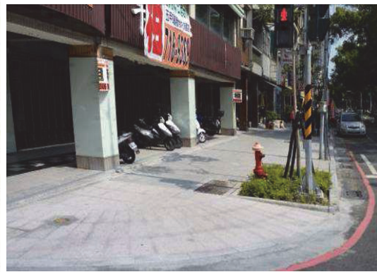
新興區民族二路施工後
