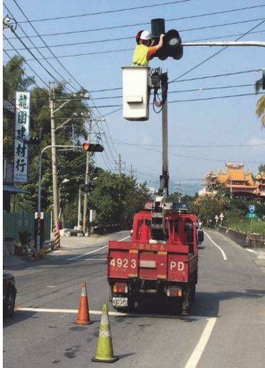
號誌維修作業-1
