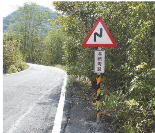
內門區高121區道增設連續彎路標誌
