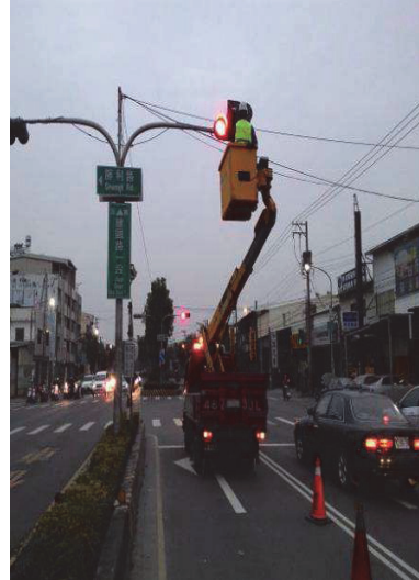
號誌維修作業-2
