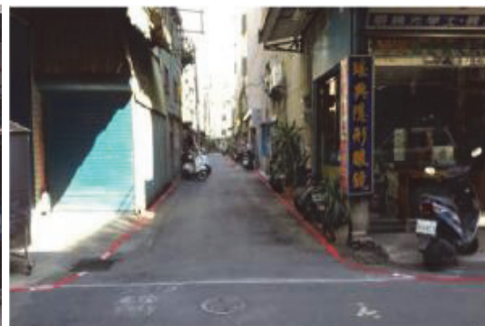
鳳山區南江街 16 巷改善後
