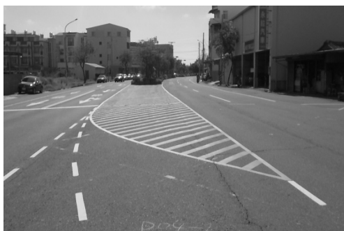
湖內區湖中路劃設槽化線
