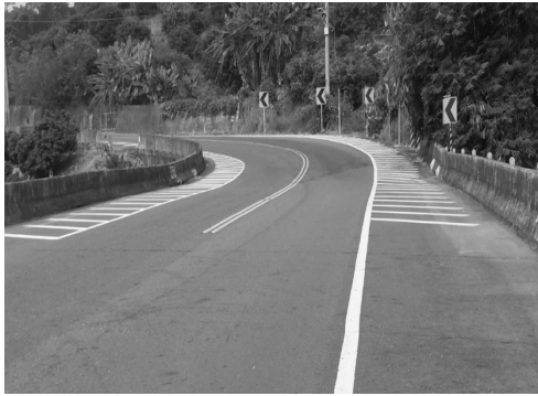
大樹區三和路設置槽化線形減速標線
