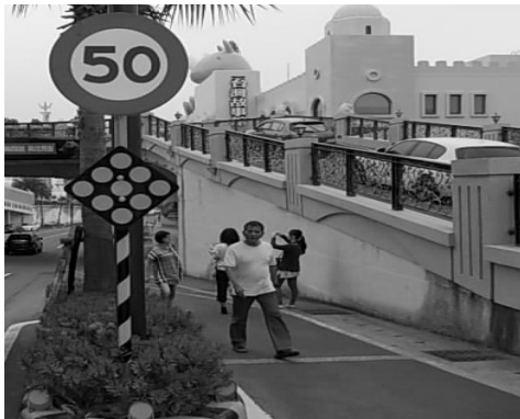
市道 186 甲學城路增設速限及危 3 標誌
