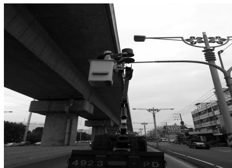
號誌維修作業-2
