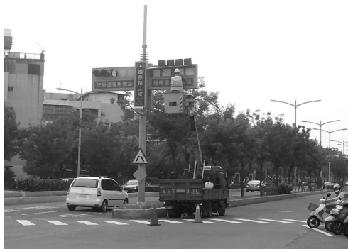
號誌維修作業-1
