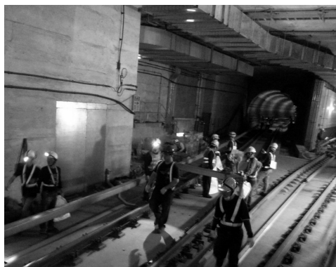
高雄車站永久軌切換
