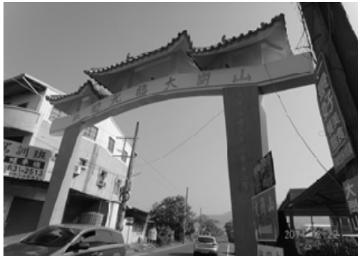
大崗山牌樓修繕
