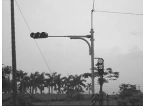
路竹長興化工前路口新設號誌
