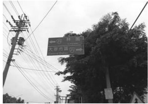
大寮區指示標誌更新作業
