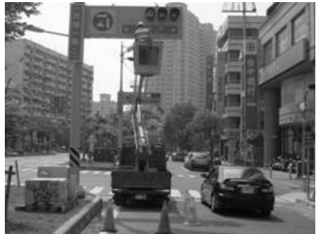
號誌維修高空作業
