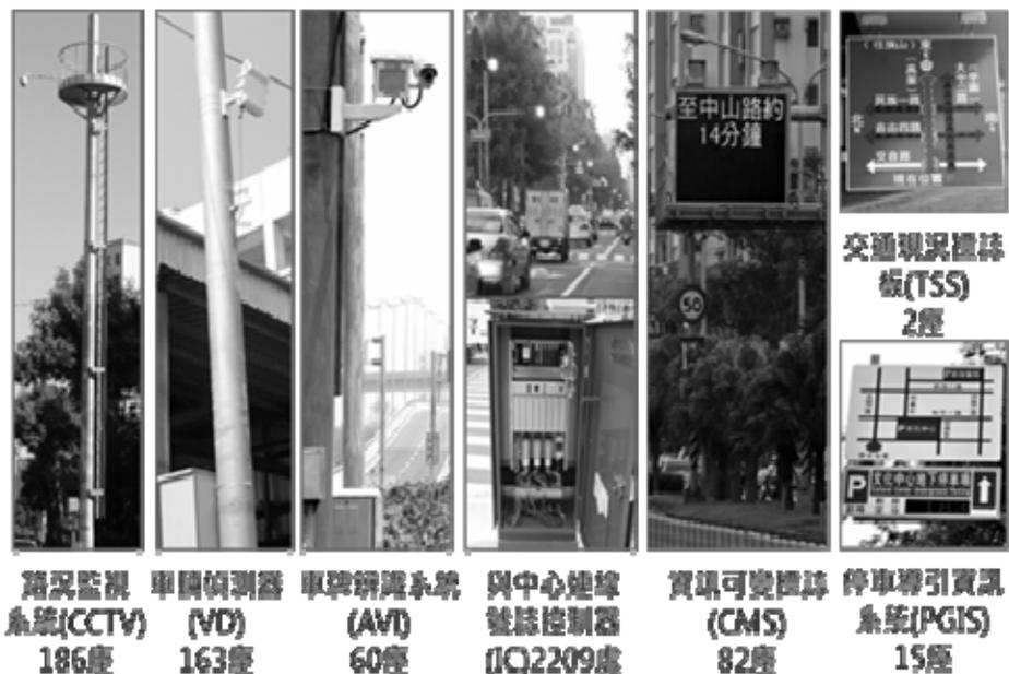
2. 為提昇整體交控系統功能，規劃 4 年 4 期「先進交通管理系統擴充工程規劃暨建置計畫」(100 至 103 年)，100 年度已完成三山地區(鳳山、岡山、旗山)主要幹道納入連線管理，及旗美智慧運輸走廊建置。101 年度賡續辦理大發工業區智慧運輸走廊建置，增加 220 處路口連線數及各項路側設備，提供即時、準確及有效之交通資訊，以紓解產業園區交通瓶頸，提昇運輸效率。目前進行交控設備佈設位置現勘及檢討，預計 102 年 1 月完成建置。
