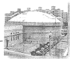
鳳山溪污水處理廠
