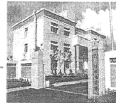
大樹污水處理廠
