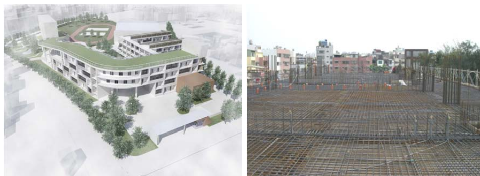
立德國中校舍改建工程
