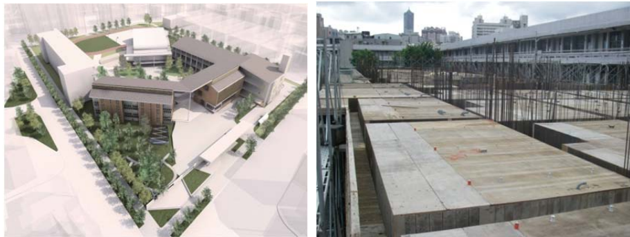
樂群國小校舍改建工程
