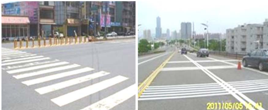
鳳山區中山東路/勝利路口交通工程改善 前鎮區中山三路/時代大道增繪減速標線
