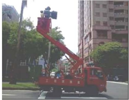
號誌高空維修作業
