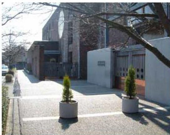
■ 写真 3-1-1 サービス部門の防犯対策例 *給食室への搬入車両用に門扉を設け単独のセキュリティの領域をつくっている。手前が正門、正面が給食室への搬入車両用の門扉。
