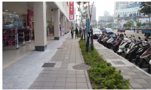
苓雅區三多三路施工後
