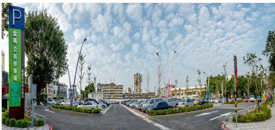
金馬公有停車場完工情形
