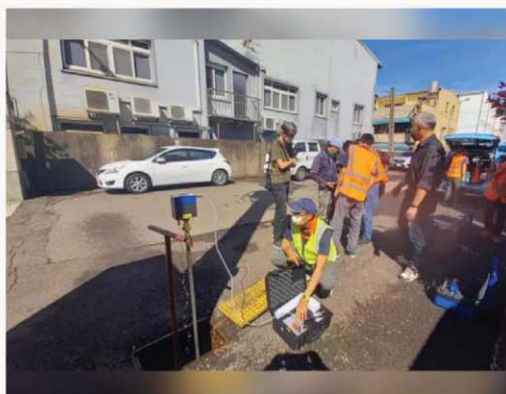
台水公司經緯員利用非金屬自來水管檢測器，偵測地下自來水管線是否漏水。圖／台水公司提供
