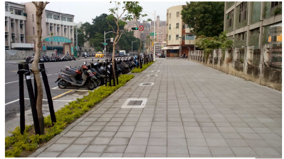
鳳山區建軍路施工後
