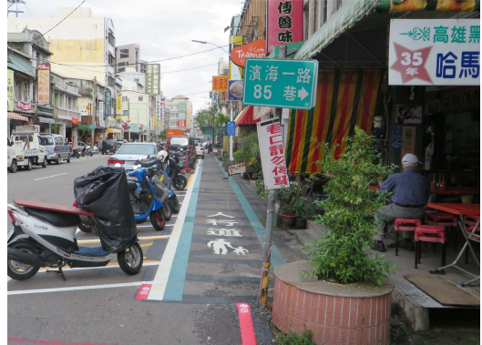
濱海一路標線型人行道(施工後)
