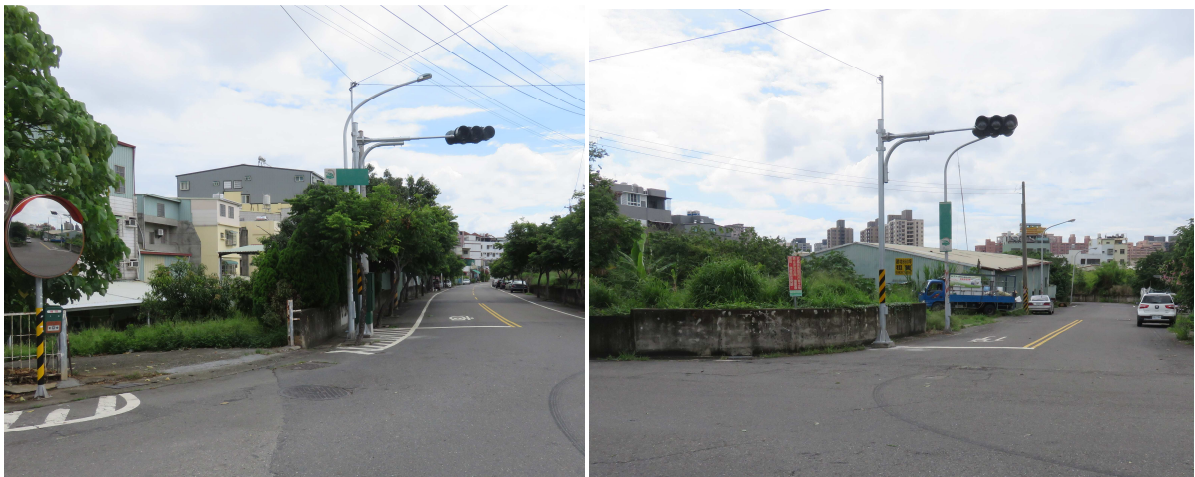
烏松區竹安街與長青街口新設號誌
