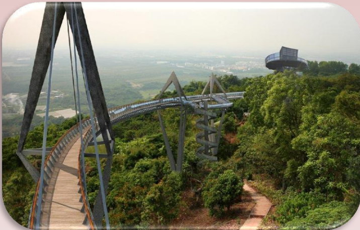
小崗山天空步道園區整建工程
