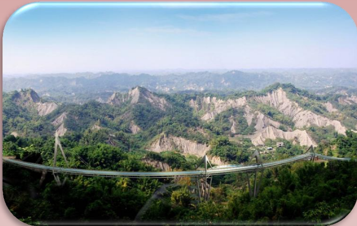
308高地俯瞰式觀光設施工程
