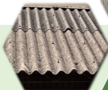
石綿浪板 屋頂/雨遮
