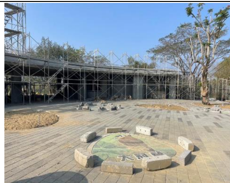
內門觀光休閒園區施工現況
