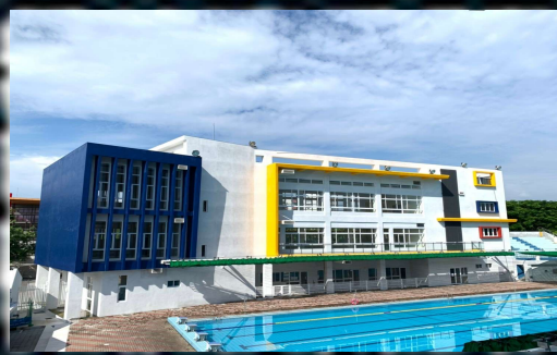
鳳山運動園區 108.12 全區完工
