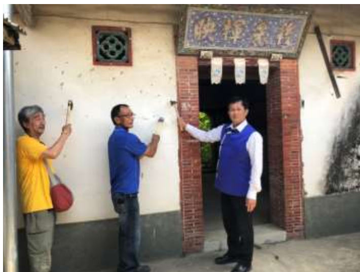
[圖 26] 邱義生夥房整修工程開工
