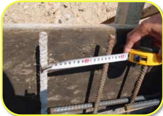
◎檢查鋼筋間距
