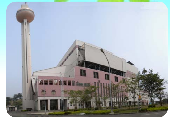
高雄市政府環境保護局 中區資源回收廠
