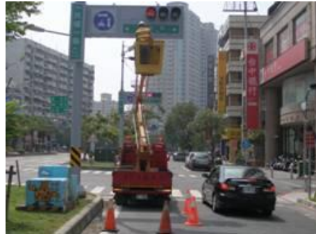
號誌維修高空作業
