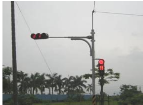
路竹長興化工前路口新設號誌
