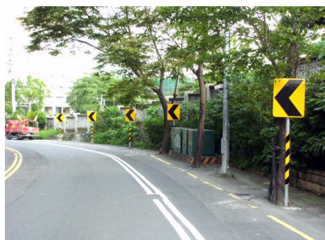
鳥松區圓山路增設輔 2 標誌
