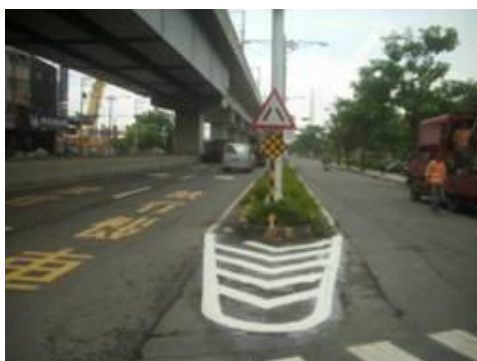
仁武區鳳仁水管路口增繪槽化線
