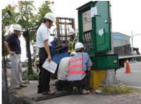
號誌控制器更新汰換
