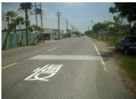
林園區溪州二路增繪減速標線及慢標字 重要路口（段）交通改善工程
