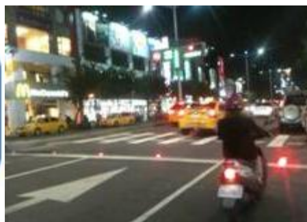
安全警示設施完工佈設情形
