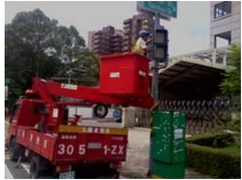
行人號誌維修作業
