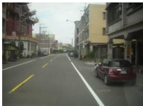
林園區溪州一路補繪縱向標線
