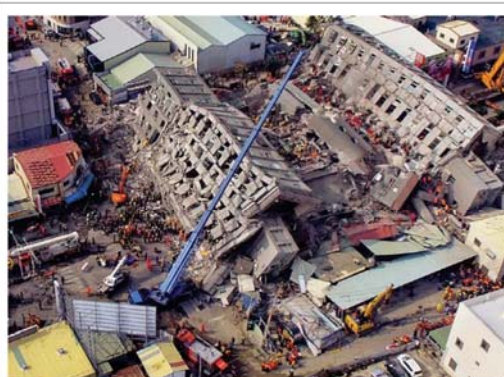
2016 年除夕前夕，台南發生 6.6 級地震，維冠金龍大樓倒塌造成 115 人罹難，此案便是建築師與鑽探技術公司提供不實簽證所致，由此可見行政委外仍須建立嚴謹的防弊及抽驗機制。(照片擷取自網路)
