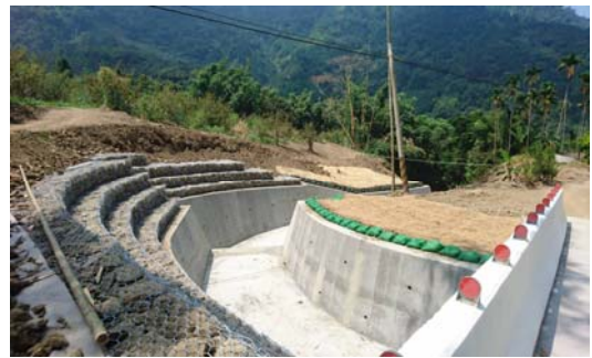
青山段福德祠下方野溪整治工程
