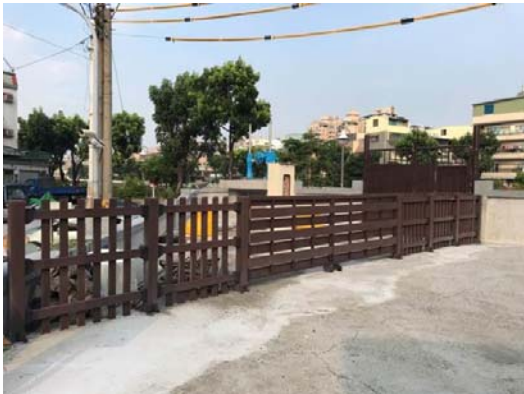
前鎮區鎮昌一巷簡易式抽水站工程
