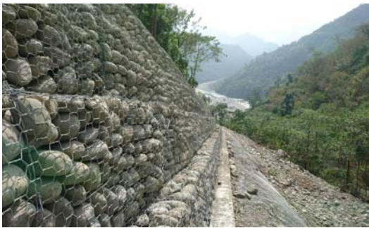
萬山部落下方崩場地處理工程
