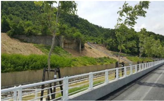
鼓山區台泥滯洪池上方裸露坡面敷蓋 及坡面排水改善工程
