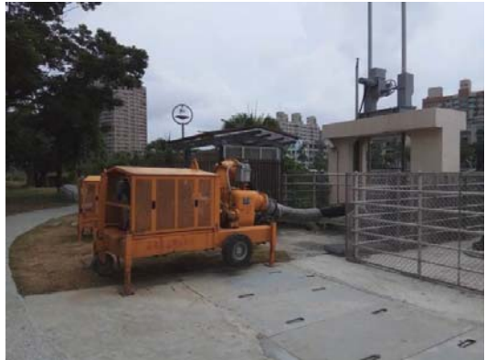
鼓山區河西一路抽水站功能提升工程
