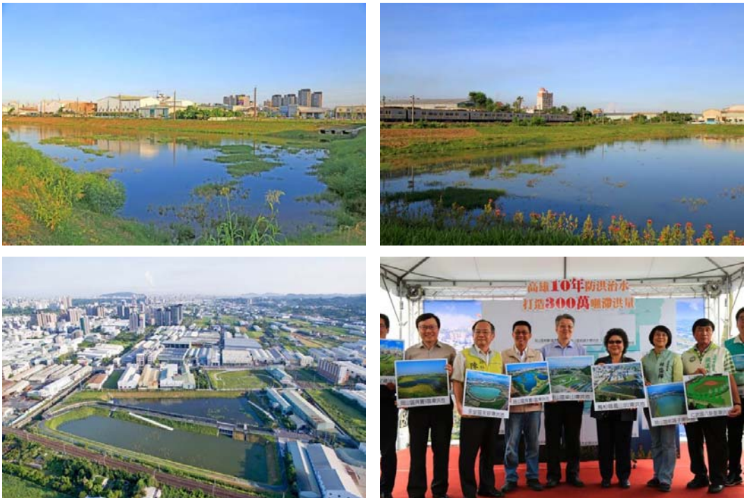
鳳山圳滯洪池
