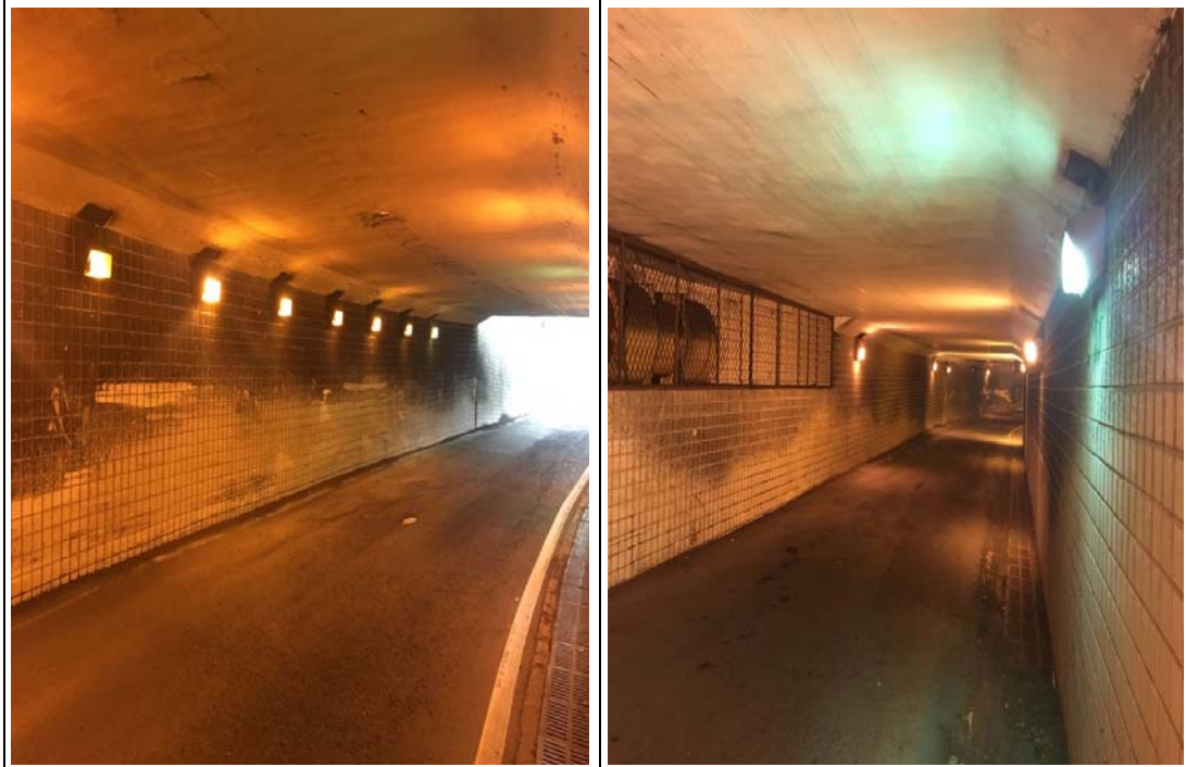
楠陽橋機車地下道
