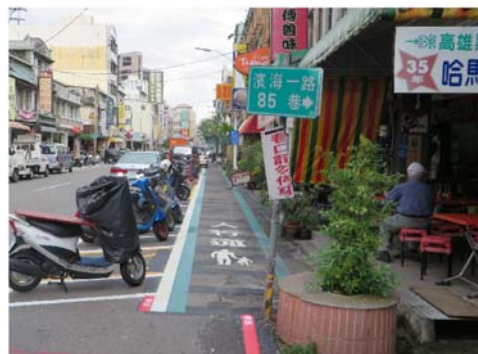
濱海一路標線型人行道（施工後）
