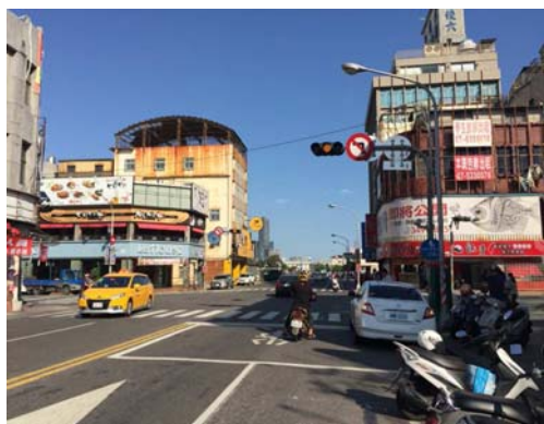
臨海一路、臨海二路口號誌管線地下施工前
