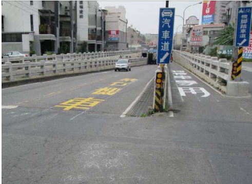
岡山區大德一路與永樂街口增繪「禁行機車」及「機車專用」標字
