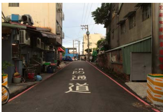
鼓山區濱海一路 57 巷消防禁停標線
