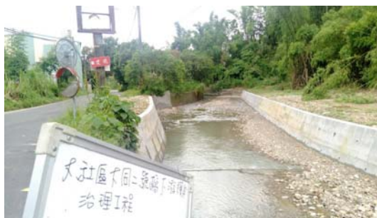
大社區大同二號橋下游護岸治理工程
