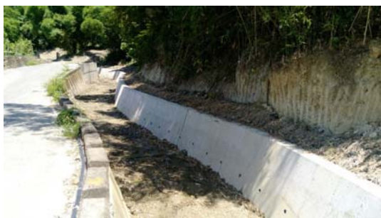
大占巷破車籠排水改善工程
