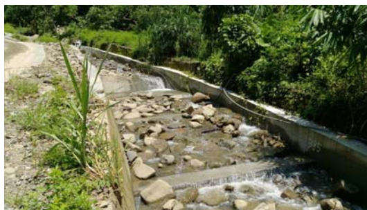
內門區十三甲二仁溪支流排水護岸工程
