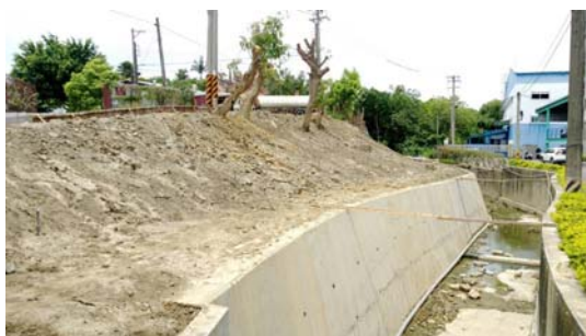
大寮區內坑里內坑路旁野溪治理工程
