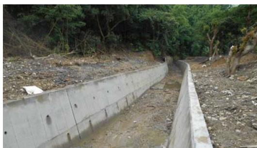
大樹區姑婆寮段 22 等地號旁野溪整治工程
