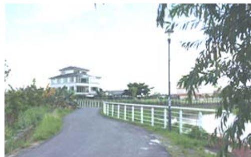
美濃區生態景觀廊道改善工程
