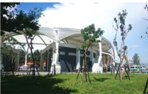
西子灣遊客服務中心新建及周邊環境整建
