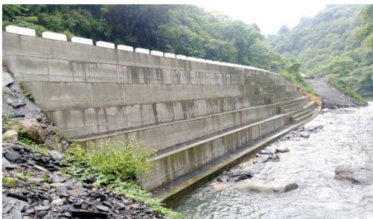
茂林區木勝溪護岸修復工程
