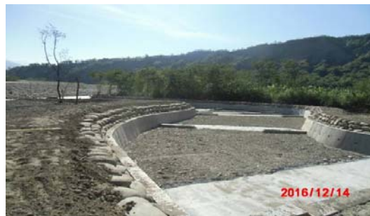
蜈蚣潭龍虎山高市 DF021 土石流 潛勢溪流整治工程
