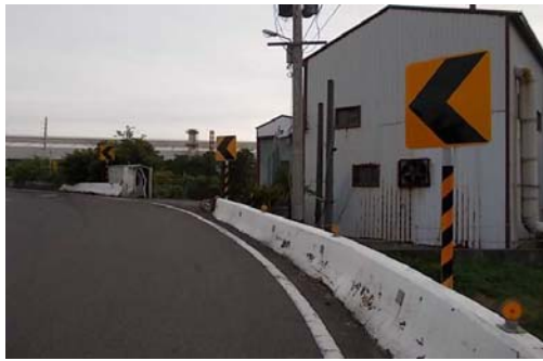
岡山區鹽埔橋新設輔 2 標誌
