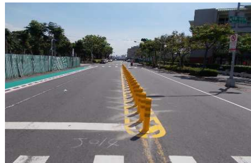
鳳育路(南華一路 82 巷至鳳甲二街)增設軟質分隔桿
