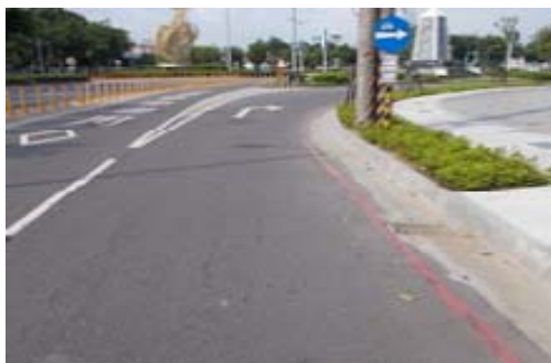
施工前（油漆標線）
