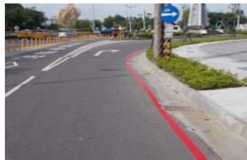
施工後（熱拌標線）
