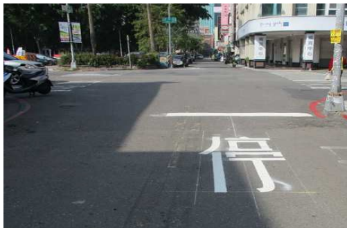
鼓山區富國路/嘉慶街劃設停止線及停字 (二)辦理優化路口（段）交通設施改善
