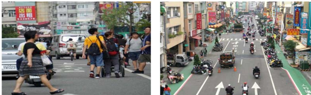
道路：濱海一路標線型人行道（左：改造前、右：改造後）
