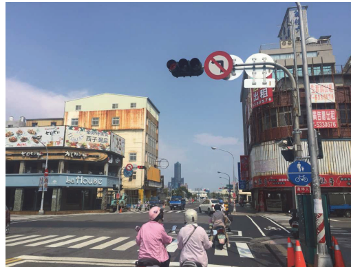
臨海一路、臨海二路口號誌管線下地施工後
