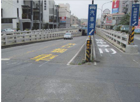
岡山區大德一路與永樂街口增繪「禁行機車」及「機慢車專用」標字
