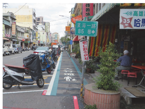
濱海一路標線型人行道（施工後）
