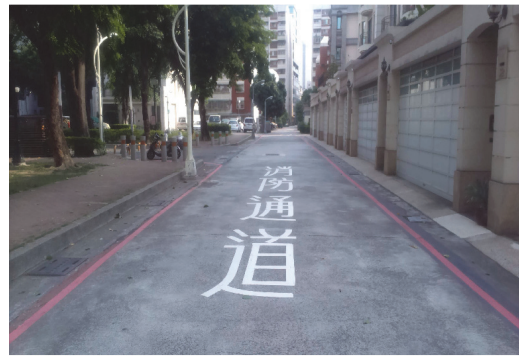
一心二路 32 巷消防禁停標線
