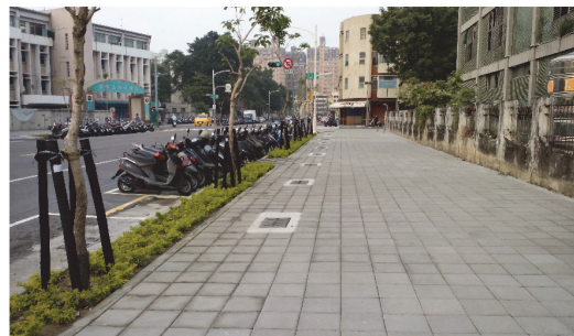
鳳山區建軍路施工後
