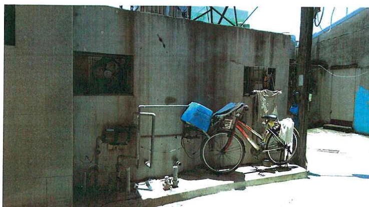
731-1 地號-寺廟右後方（盥洗室位置）
